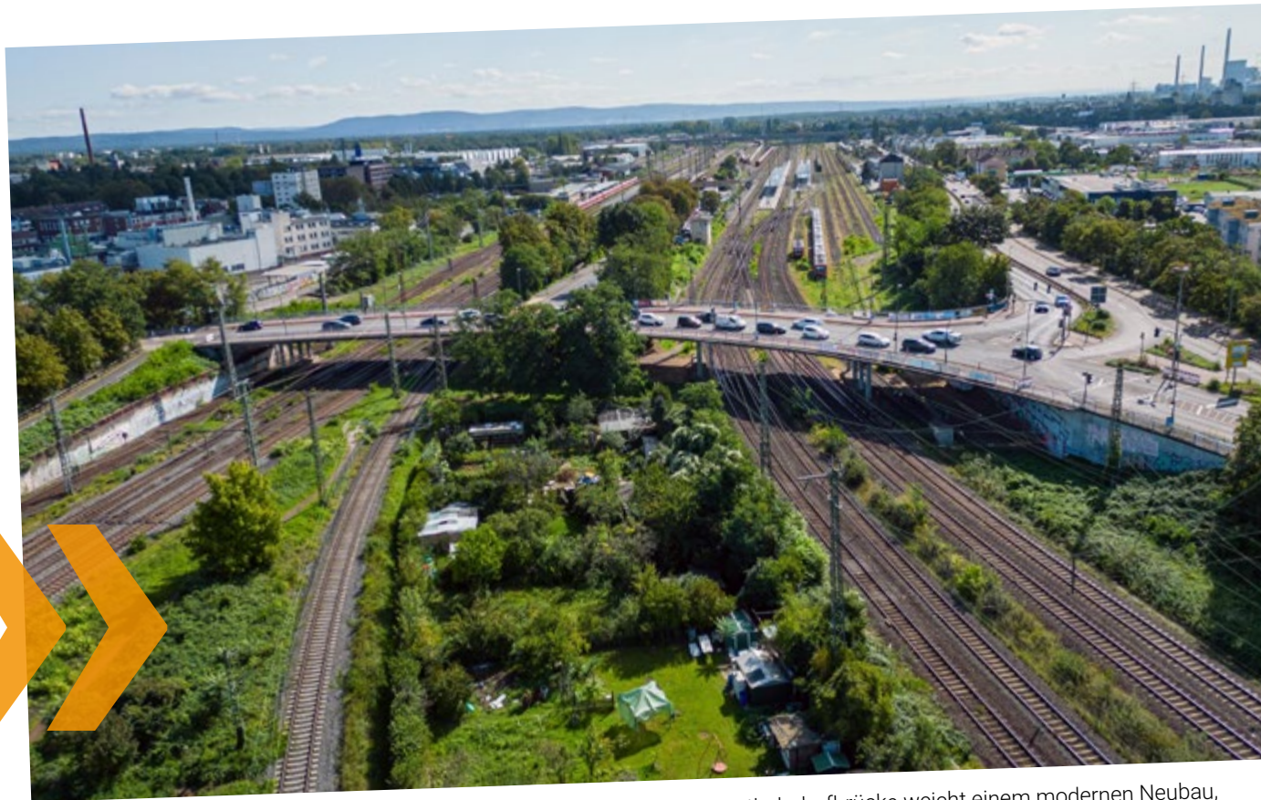
Die 1958 erbaute Hauptbahnhofbrücke weicht einem modernen Neubau, die vorbereitenden Bauarbeiten begannen 2023.
